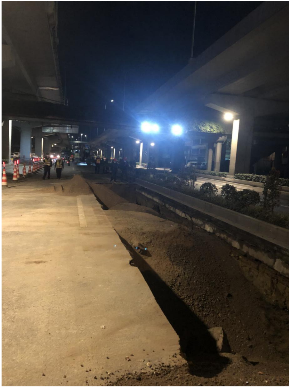
图 2 事发施工坑道
