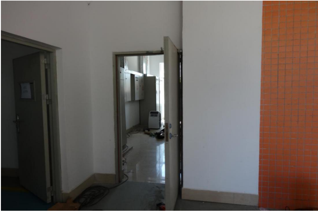
图 2 事发配电房外部
