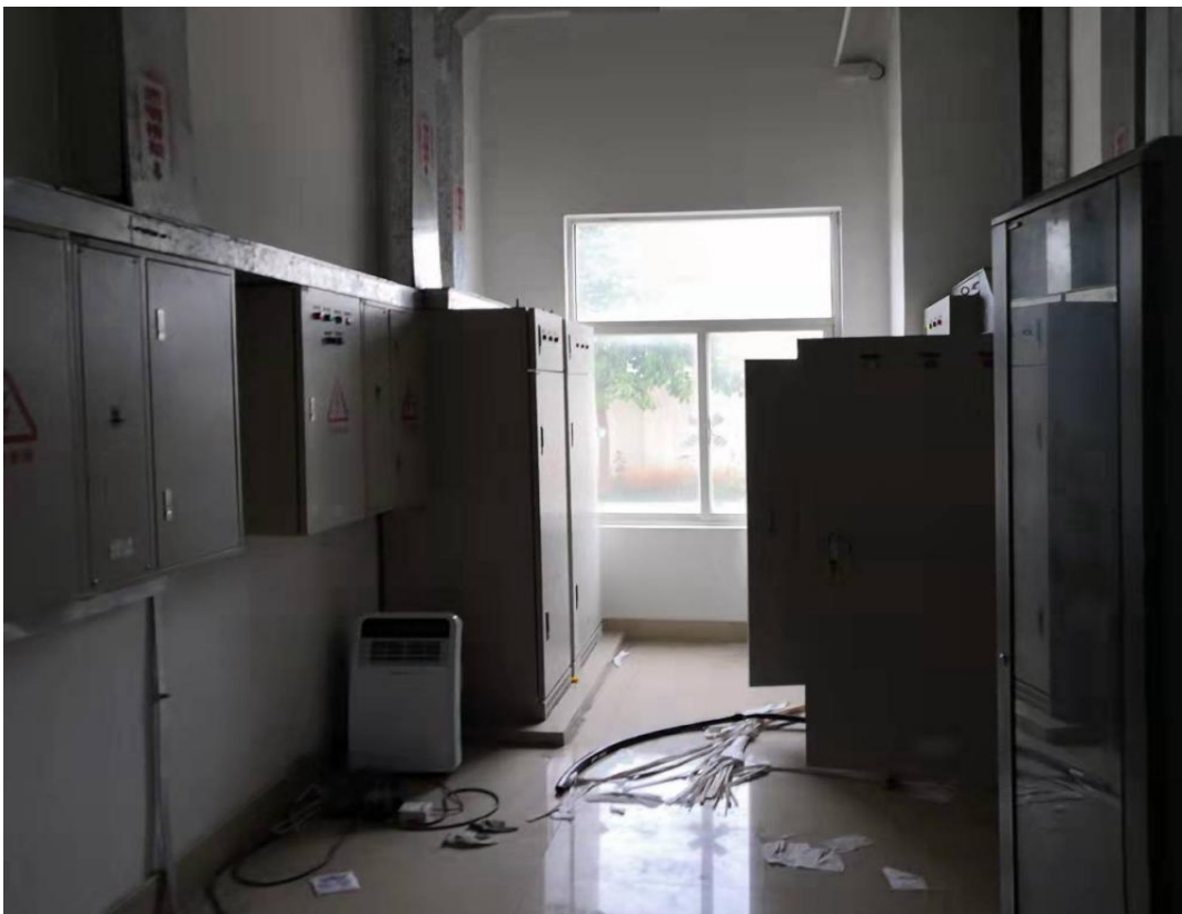
图 3 事发配电房内部
