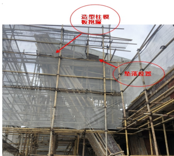
图6 作业现场全景
