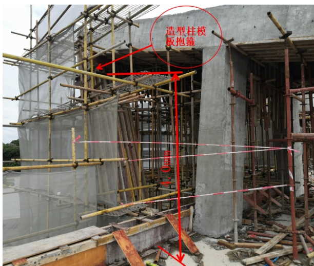
图5 拆除造型柱抱箍工作面
