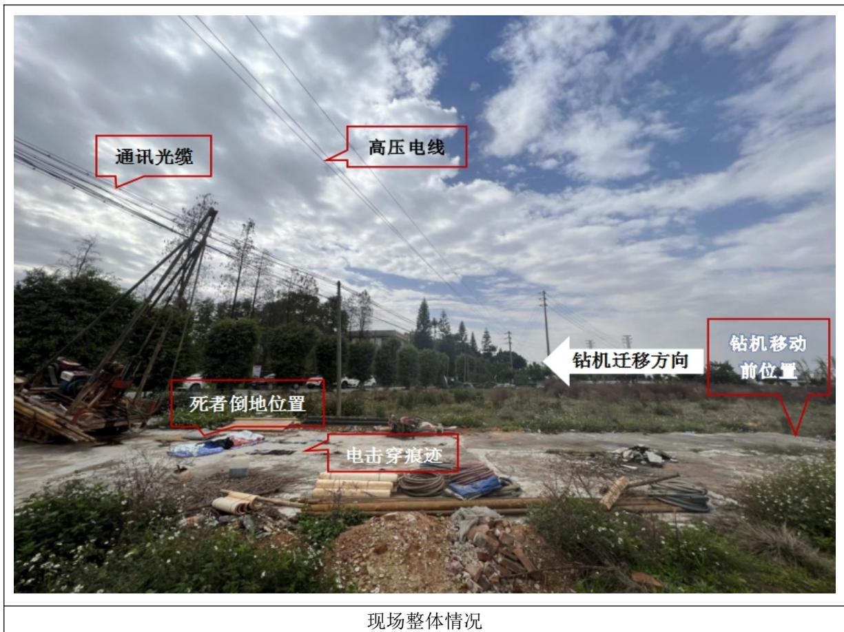
2. 涉事钻机由上下两部分组成，上部分为钻探机械装置（含塔架），下部分为机台履带车，机台履带车动力装置为欧玛牌 S105 柴油机，钻探机械装置的动力装置为常柴牌 ZS1110 柴油机，全套机台除履带和操作手柄带绝缘外均为可导电金属材质。事发后钻机停在架空通讯线路下方，上端靠在通信架空通信线路上，下端机台履带一端翘起。
