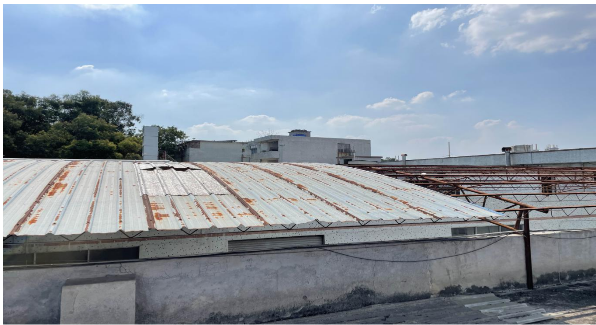
铁棚顶部情况
