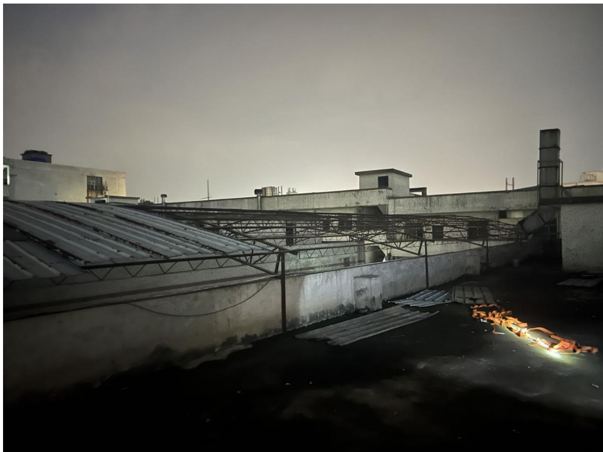
楼顶天面的安全绳
