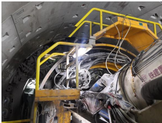
图 3 管片拼装作业平台、走道 (左上部)
