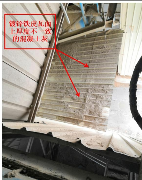
图 5 镀锌铁皮瓦顶面情况
