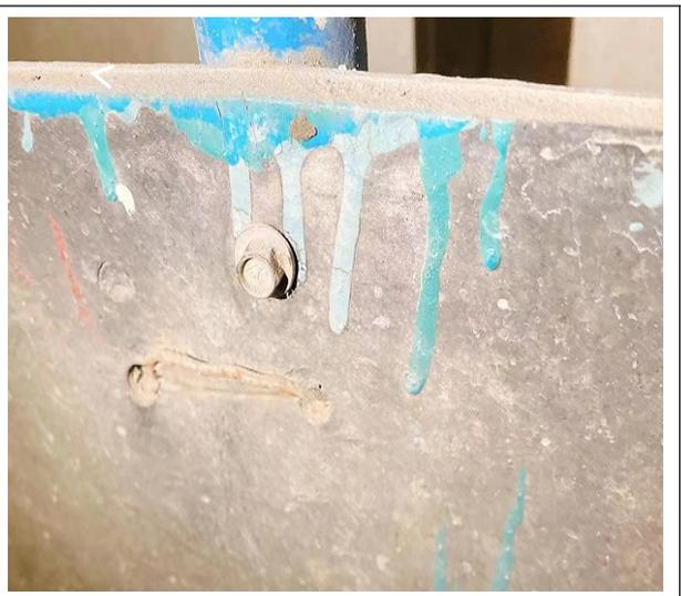
图 11 安装橡胶垫的螺栓
