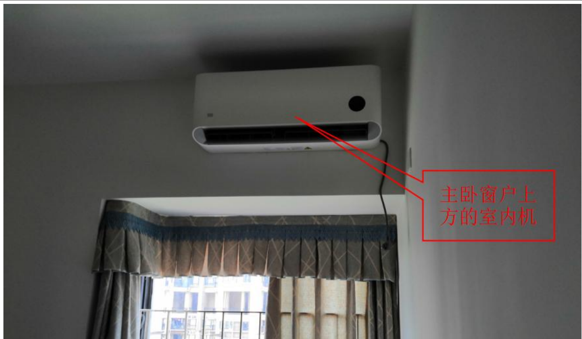
图 7 已安装的空调室内机
