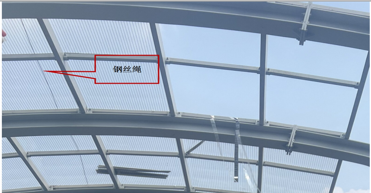
图 4 道路声屏障顶部设置钢丝绳情况
