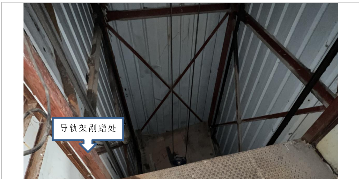
图 7 井道内的导轨架
