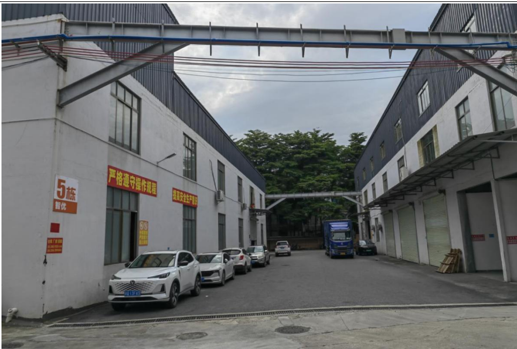
图 1 事故发生场地，左侧建筑为广州超时代公司仓库（非现场拍摄）
