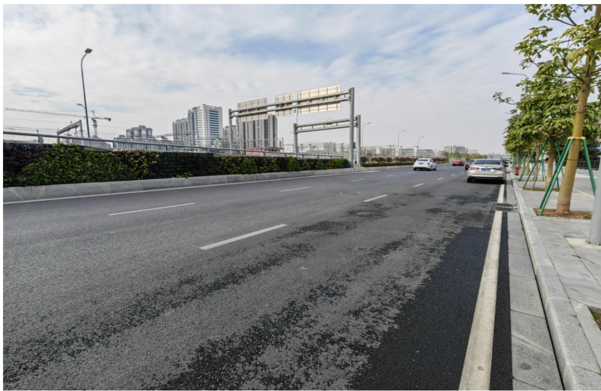
图 2 事故现场原址现况
