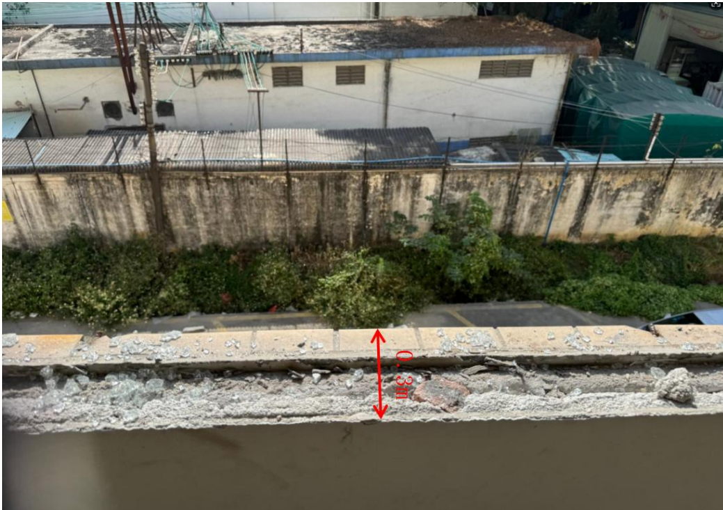
图 5 涉事窗户洞口下侧墙体厚度情况
