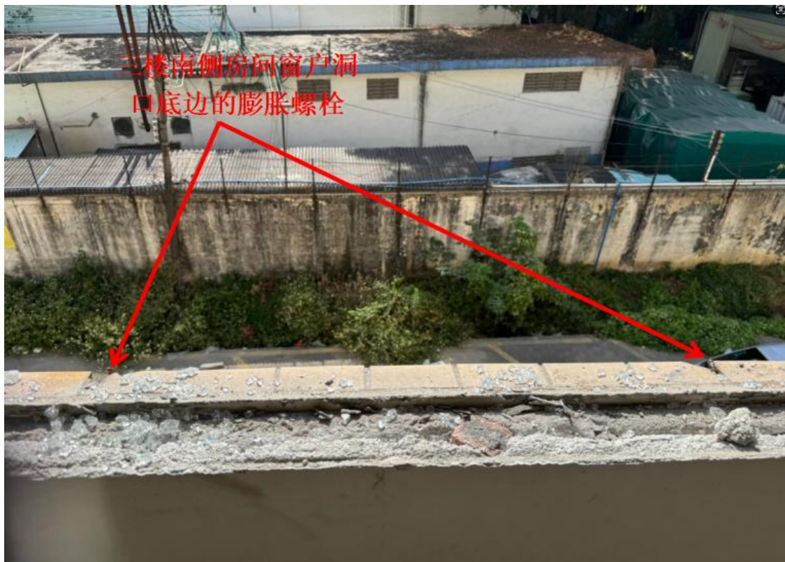
图 7 事发点洞口底边的膨胀螺栓
