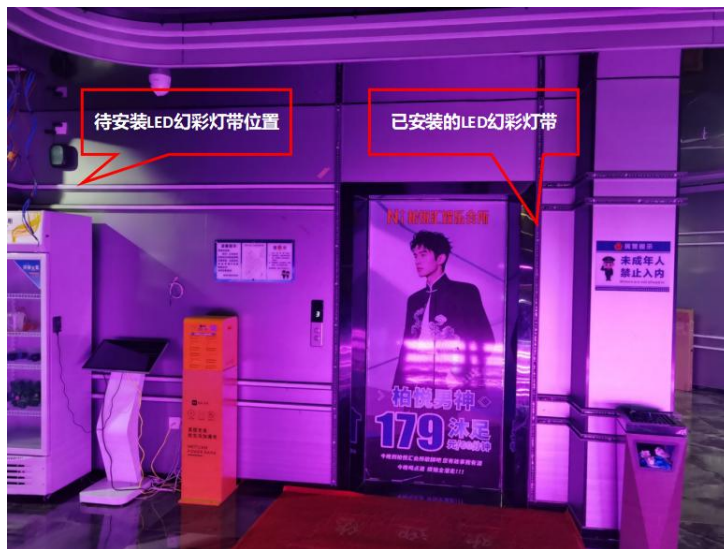
图 5 现场 LED 幻彩灯带安装情况
