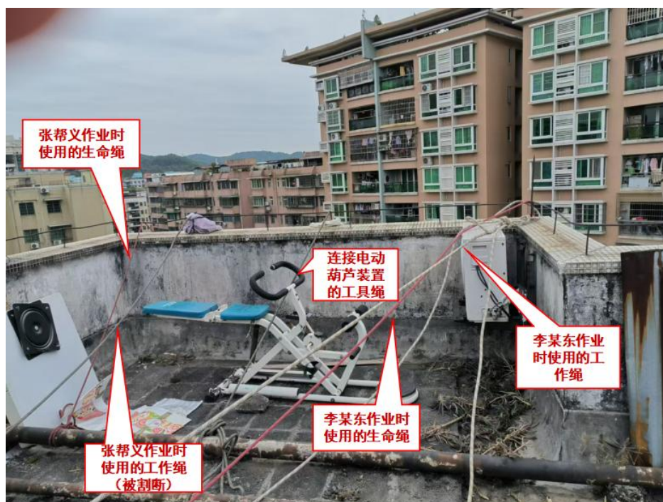
图 3 涉事作业 5 根绳子连接分布情况
